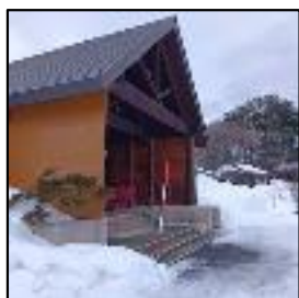
宿舎外観入口
