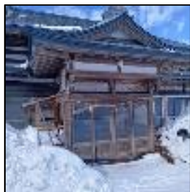
宿舎外観入口
