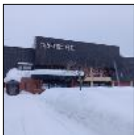
宿舎外観入口
