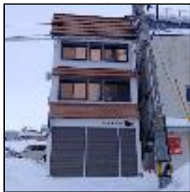
宿舎外観入口
