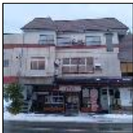
宿舎外観入口
