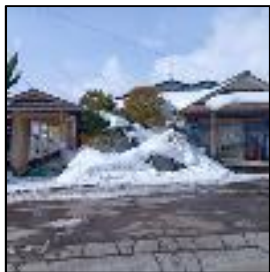
宿舎外観入口
