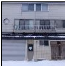
宿舎外観入口
